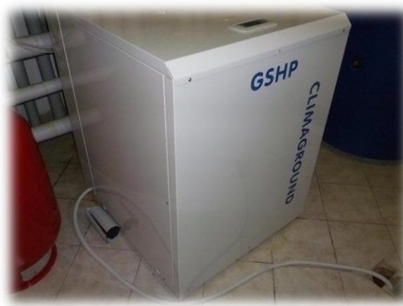
FIGURA 3 – POMPA DI CALORE TERRA-ACQUA
