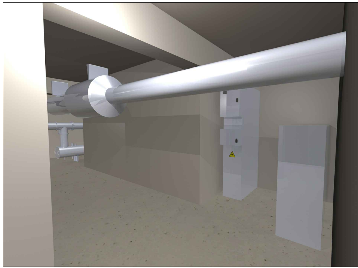
SILENZIATORE E QUADRI ELETTRICI
